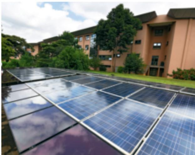
6000平米的太阳能电池板为整栋大楼提供电力供应，为办公楼中的电脑、照明、餐厅和大楼的其他设施提供电能
